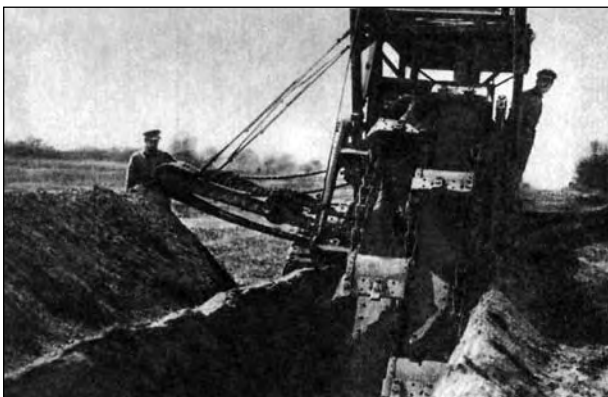
Роторный траншейный экскаватор
