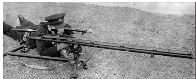
Рис. 2. Опытный образец ПРО-82-П.Б. со снятым щитком в положении стрельбы. Предположительно за прицелом техник-лейтенант Первицкий Ю.Д. Филиал ЦАМО (архив ВМФ) Ф. 430 Оп. 1 Д. 1284 Л. 9
